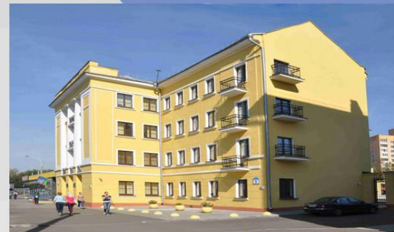
ИБМТ ул.Московская,5 ввод 2014
