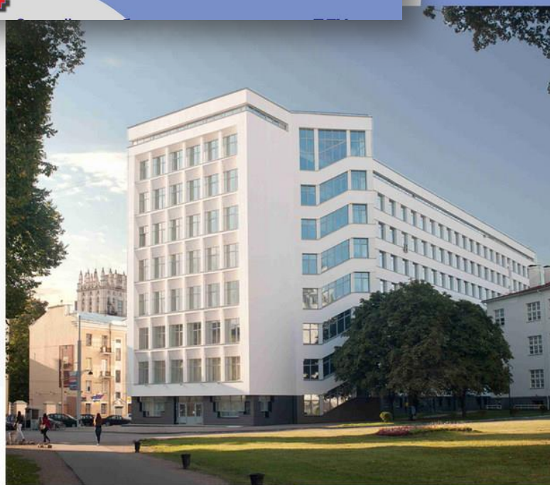
Химический факультет первый этап реконструкции ввод 2013
