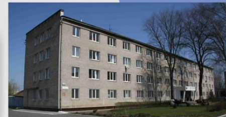
ГИУСТ (ул.Ботаническая, 15) ввод 2010
