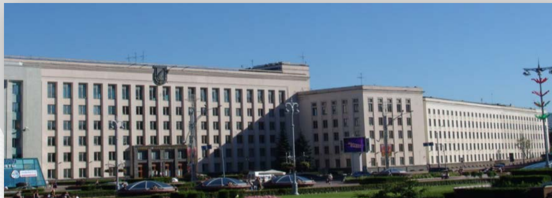
Главный корпус БГУ
