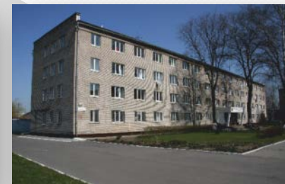
ГИУСТ (ул.Ботаническая, 15) ввод 2010
