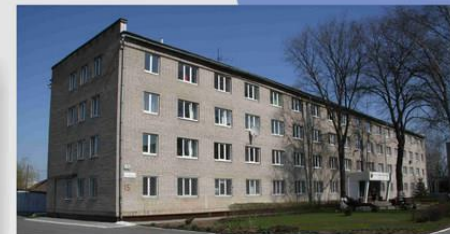
ГИУСТ (ул.Ботаническая, 15) ввод 2010
