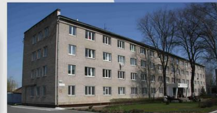
ГИУСТ (ул.Ботаническая, 15) ввод 2010
