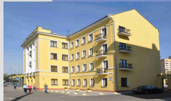
ИБМТ ул.Московская,5 ввод 2014
