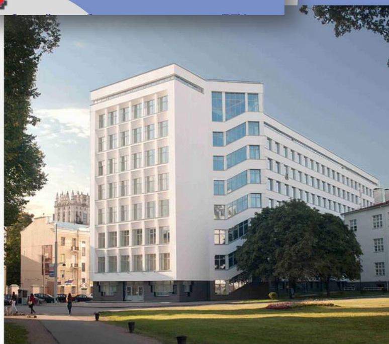
Химический факультет первый этап реконструкции ввод 2013
