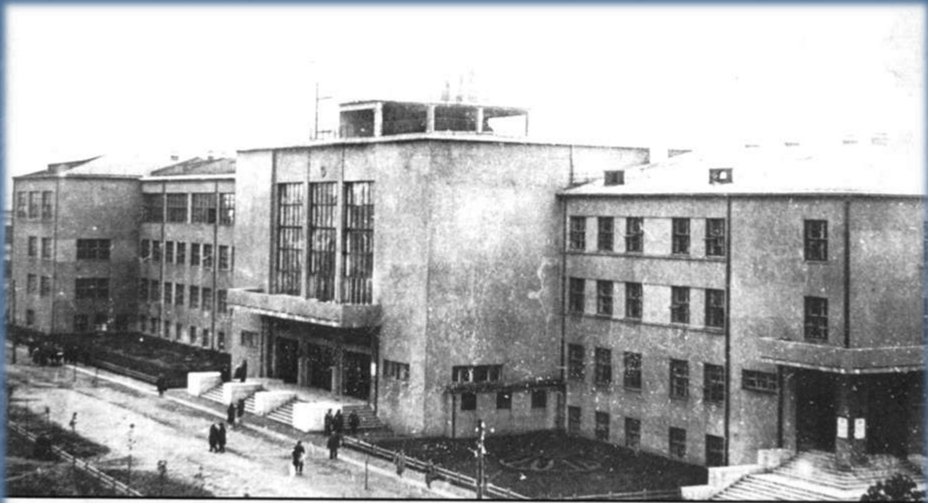
Галоўны корпус універсітэцкага гарадка. 1934 г. (цяпер – корпус МДПУ імя М.Танка)
